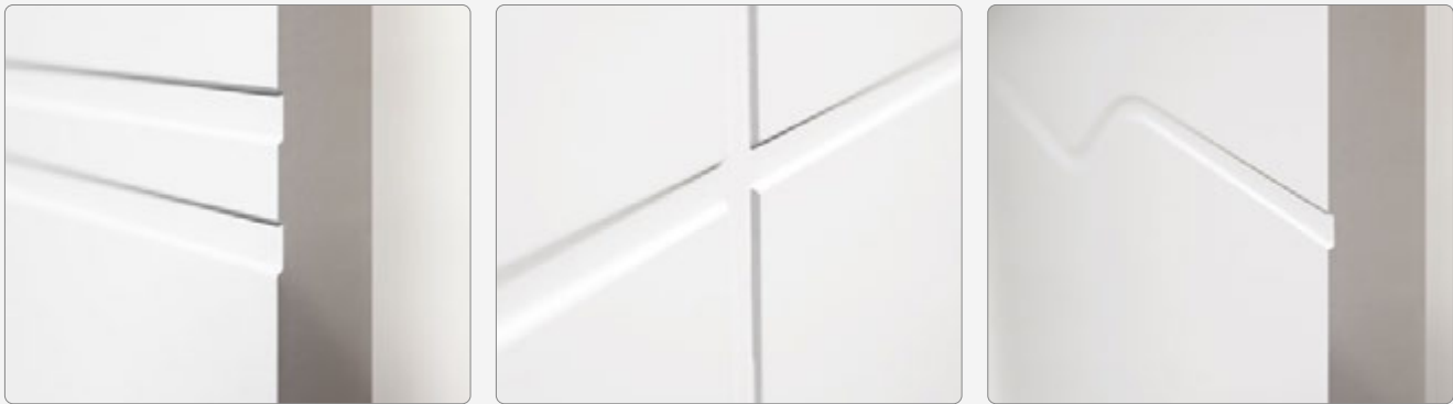
Die flach ausgeführten Rillenfräsungen wirken besonders elegant und lassen saubere und glatte Übergänge, auch bei sich kreuzenden Linien, zu.
