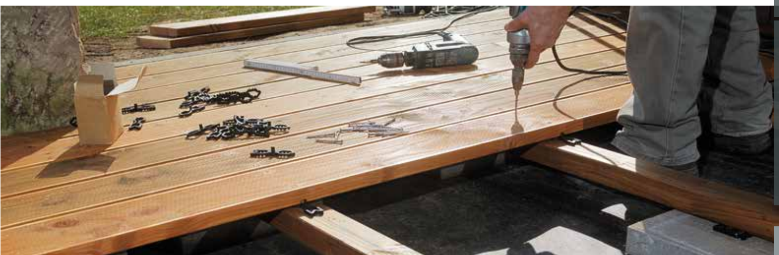
Terrassenlager CLIP 25-40 / 35-70 / 65-155 / 145-225 mm
