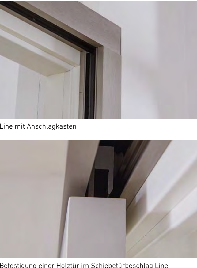
Befestigung einer Holztür im Schiebetürbeschlag Line
